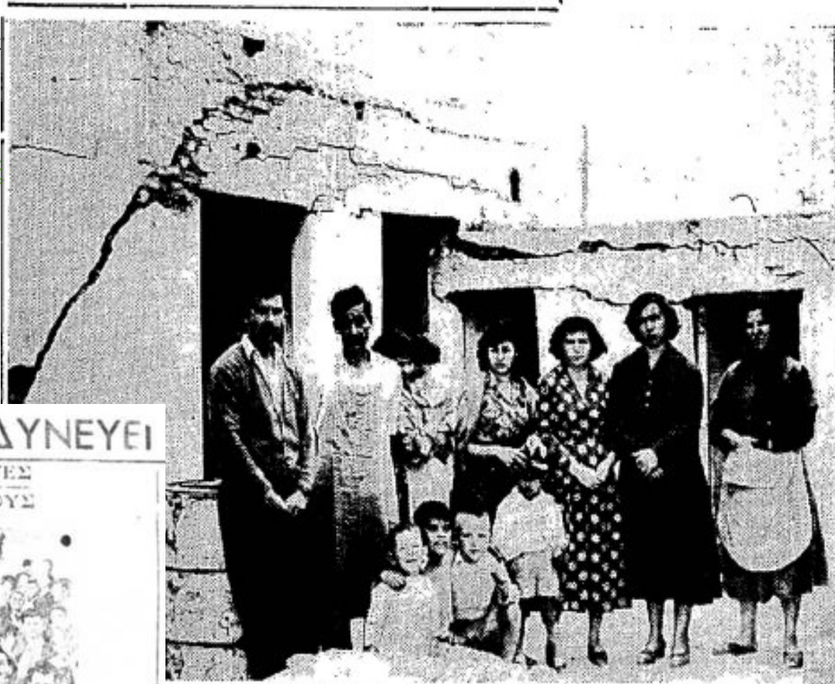
γεγονότα της Άνθουπόλεως, οι κάτοικοι της οποίας έπυρπόλησαν προχθές την γόττα τής σεις τήν εκεί λιγνιτωρυχείαν. Ανωτέρω: Ένα σπίτι που υπέστη καθίλας ρωγμάς από το-θ έδαφος, όφειλομένης έις τήν λειτουργίαν τών λιγνιτωρυχείων και του όποιου ει κάτω και τό εγκατέλειψαν φοδούμένοι κατάρριυσίν του
